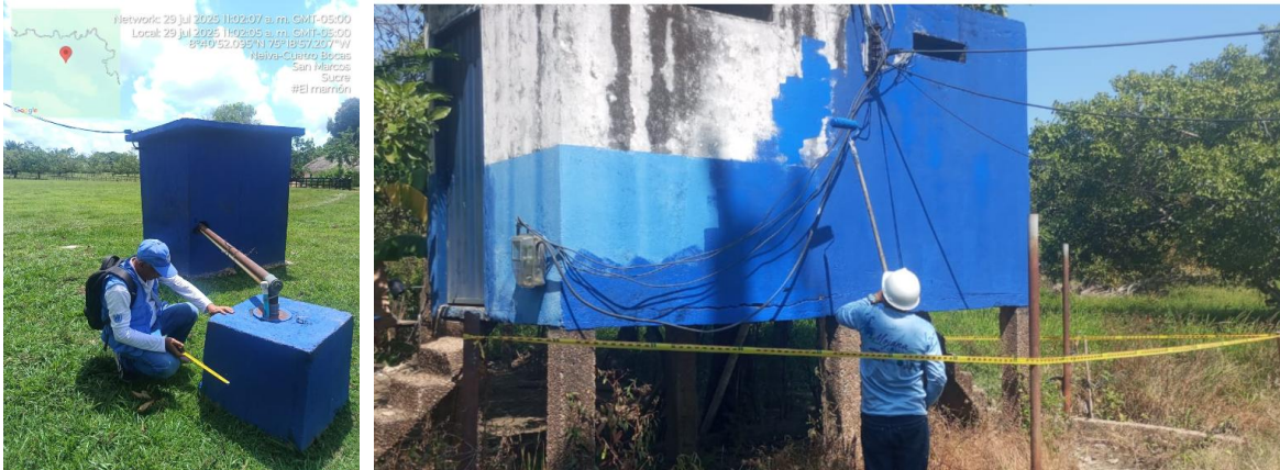
Figura 2. Pintura de caseta
