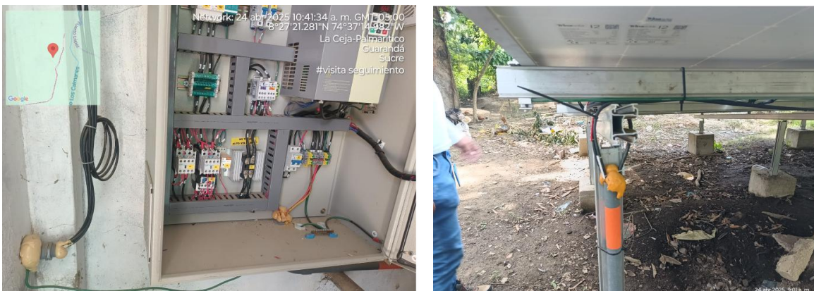
Figura 3. Sellado de componentes de la solución solar
